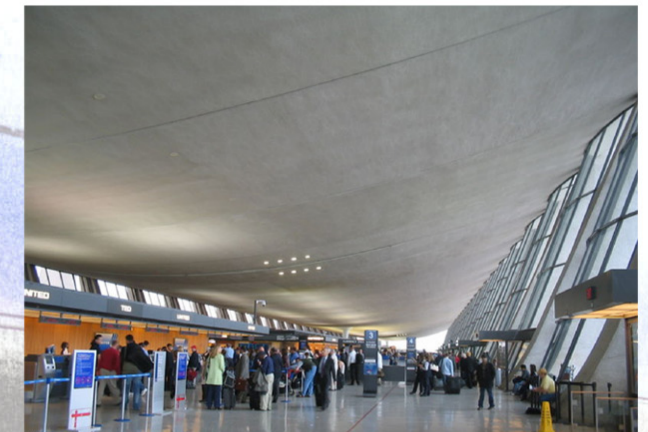
DULLES AIRPORT (1958-62): OTRA OBRA MAESTRA DEL GENIAL EERO SAARINEN, SITUADO EN CHANTILLY, VIRGINIA, AUNQUE EN REALIDAD ES EL AEROPUERTO COMERCIAL DE WASHINGTON D.C. ESTE EDIFICIO EXPRESA INMEJORABLEMENTE LA EMOCIÓN DE INGRAVIDEZ O FLOTABILIDAD DE SU CUBIERTA CURVA.
